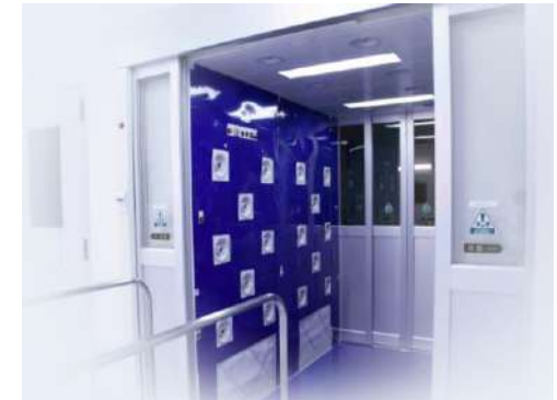
クリーンルーム
